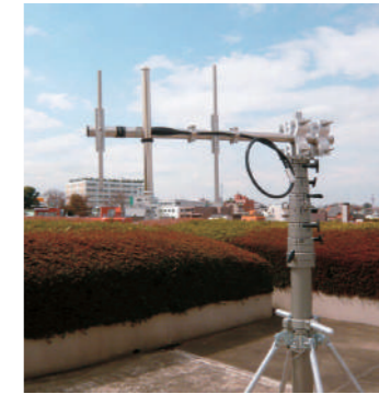
2局間無線通信用 (通信会社) TPM-8使用
